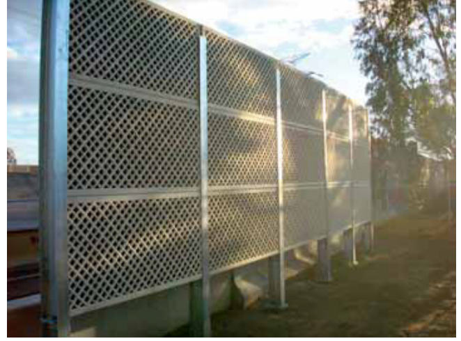
Şekil 6: Cam Elyaf Takviyeli Betondan inşa edilmiş emici ses bariyerleri, Avustralya.
