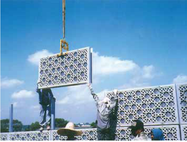
Şekil 5: Cam Elyaf Takviyeli Betondan inşa edilmiş emici ses bariyerleri, Malezya.
