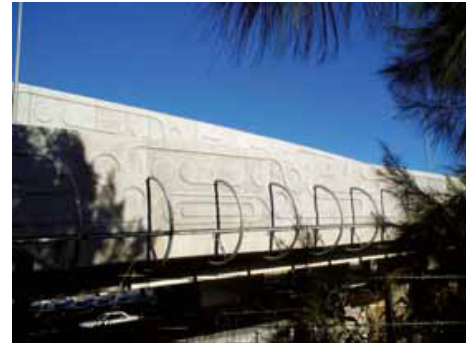
Şekil 3: Glebe Island Çıkış Şeridi, Avustralya – Cam Elyaf Takviyeli Betondan inşa edilmiş yansıtıcı ses bariyerleri.
