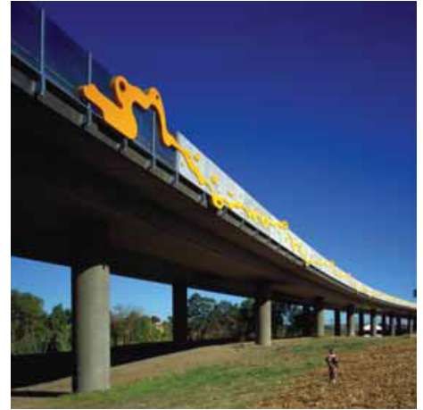
Şekil 4: M4 Otoyolu, Parramatta, Avustralya – Cam Elyaf Takviyeli Beton ve akrilik paneller.
