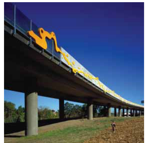
Figura 4: Autopista M4 en Parramatta (Australia): HRFV y paneles acrílicos.
